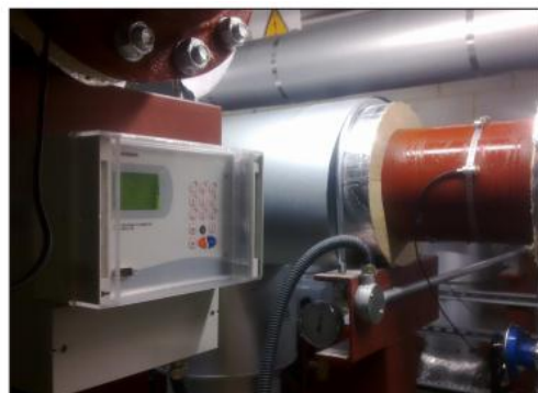
Применение KATflow 150 для измерения кол-ва тепла при помощи датчиков PT100
